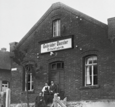
Schuhfabrik der Gebrüder Dassler 1927
