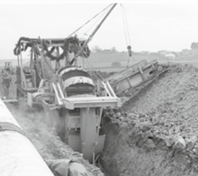
Spatenstich zur Pipeline Karlsruhe-Ingolstadt, 10.05.1963
