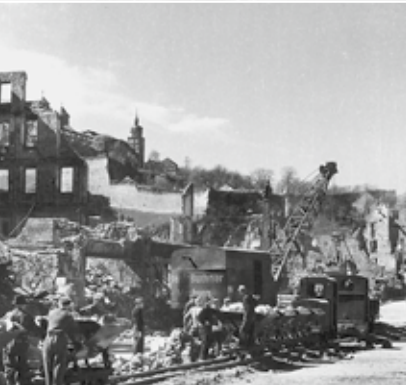
Räumung von Kriegstrümmern in Würzburg
