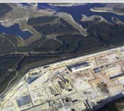
Bau der geplanten Wiederaufbereitungsanlage Wackersdorf
